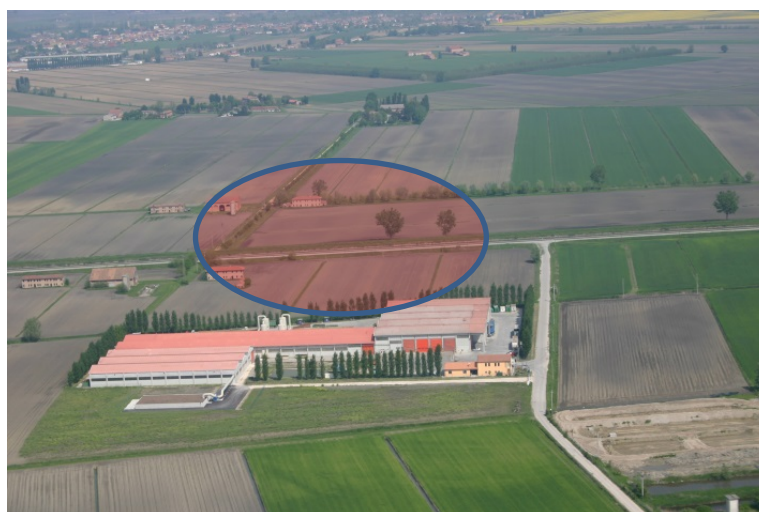
Foto 1 Area impianto di selezione TMB di Sarzano
