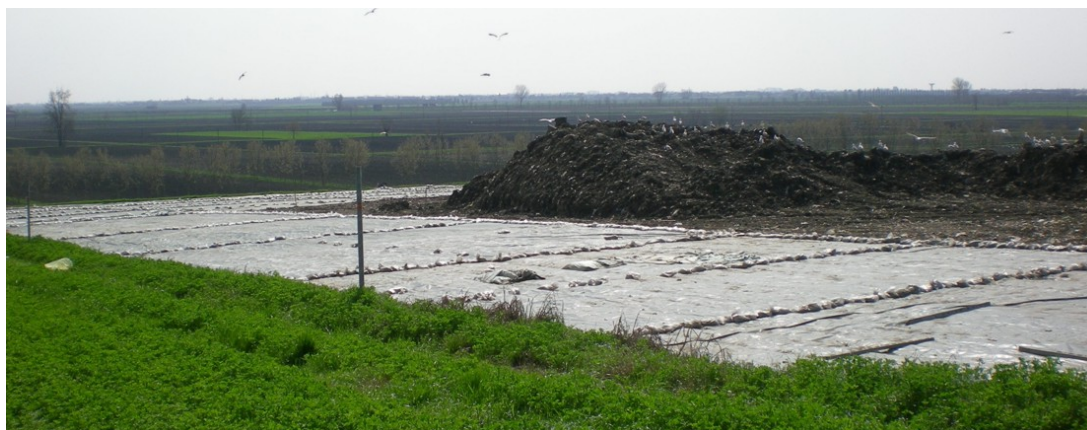
Esempio di zona di discarica in gestione, in copertura provvisoria, e copertura definitiva
